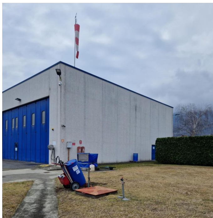
Foto 2 - Manica a Vento e dotazioni antincendio
