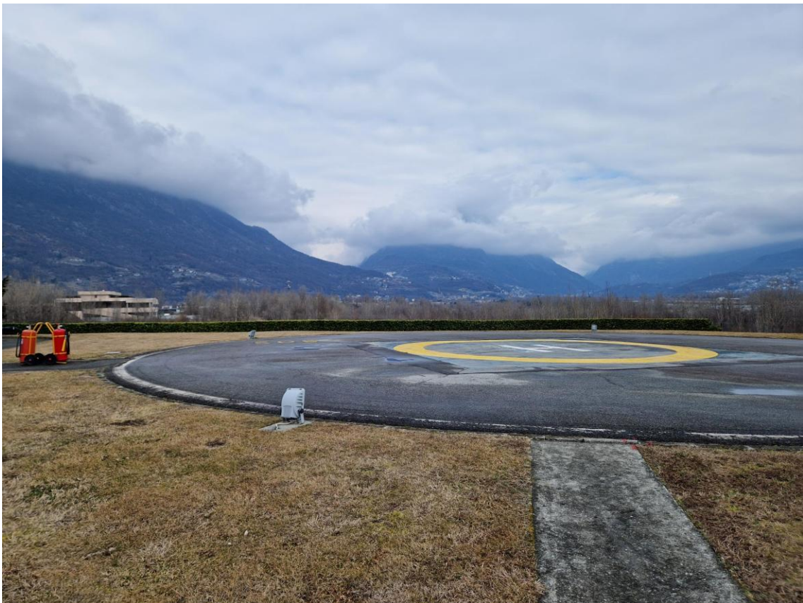
Foto 4 – Segnaletica sbiadita della pista con striscia continua bianca di almeno 30 cm di spessore
